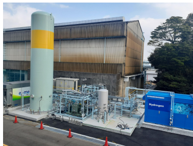
メタネーション実証設備(建設中)
